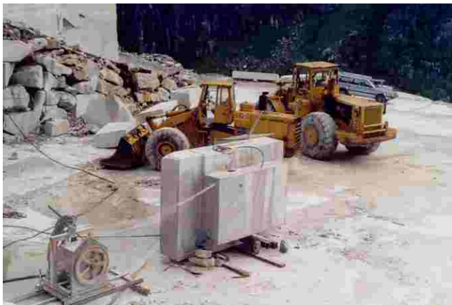
Auch die Fälze wurden mit dem Seil gesägt
