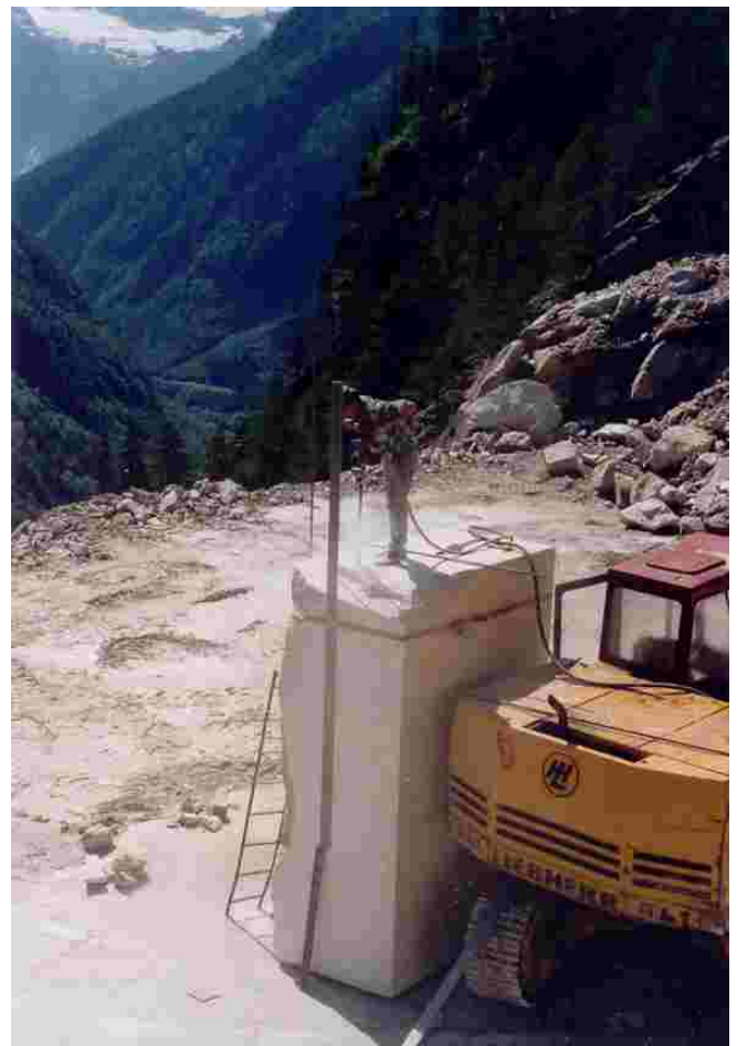
Zum Einfädeln des Diamantseiles muss ein Loch vorgebohrt werden
